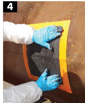
Instalación de los parches de Kevlar® con resina 3X (5 capas)
