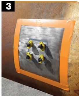
Instalación de la placa de acero (con masilla e imanes)
